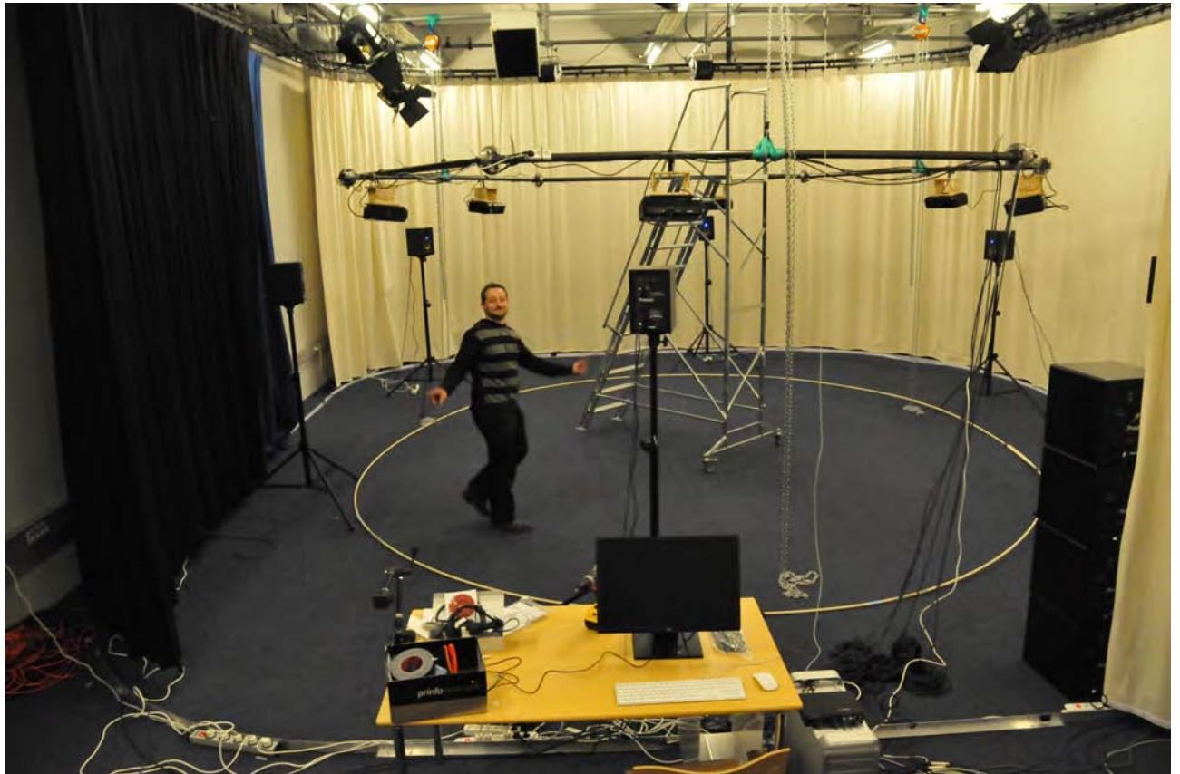
For at kunne ophænge både lærredet og projektorene var det nødvendigt at svejse et stort sekskantet lysrig i stål. Vi har benyttet 50 mm sort stålrør (~50 mm rør er standarden for ophængning af al professionel lysudstyr). Riggen er opdelt i 3 m lange rør, for at lette montage og transport. Det hele hives op under loftet af 3 stk. 0,5 T kædetaljer, så det nemt kan køres op og ned for justering og forsøg.
